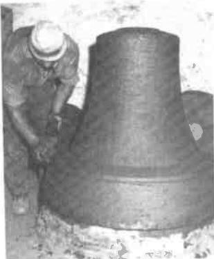
Darüber kommt der "Glockenmantel" aus Lehm. Innschrift und Verzierung werden ausgeschmolzen, der Glockenmantel gehoben und die falsche Glocke zerschlagen. Mantel und Kern (dazwischen entsteht ein Hohlraum) werden in die Erde eingegraben.
